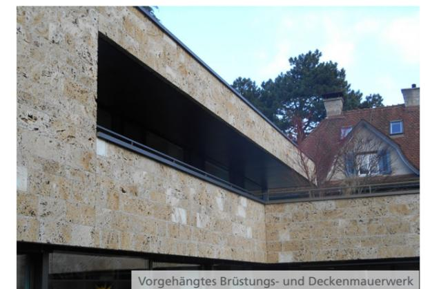
Vorgehängtes Brüstungs- und Deckenmauerwerk
